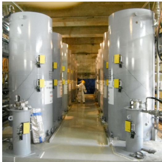
SARRY吸着塔外観写真 φ1.4m×H3.6m、24t(遮蔽体含む)
